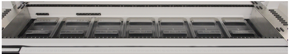
Afb. 20: Dektrays onder de deksegmenten
