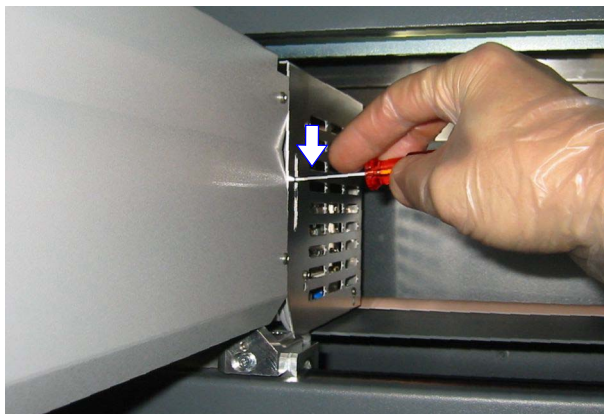
Afb. 8-3 Sleuf voor toegang tot remloszetter
